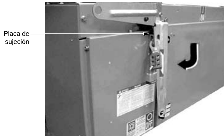
Figura 12 – Bloqueo de la palanca de la unidad enchufable, con un candado
